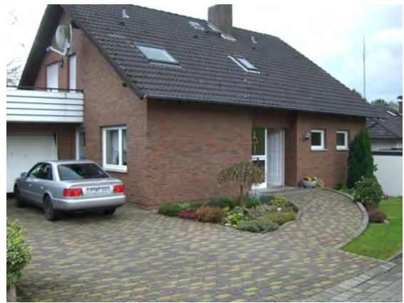
Abb. 6: freistehendes Zweifamilienhaus, Baujahr 1958
