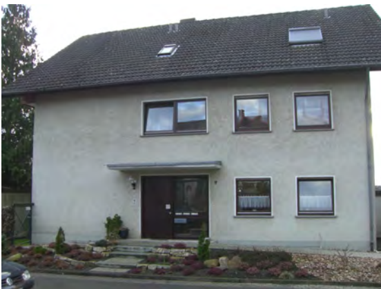
Abb. 4: freistehendes Zweifamilienhaus, Baujahr 1950
