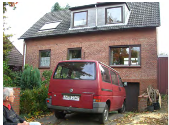
Abb. 8: freistehendes Zweifamilienhaus, Baujahr 1976
