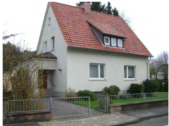
Abb. 5: freistehendes Zweifamilienhaus, Baujahr 1954
